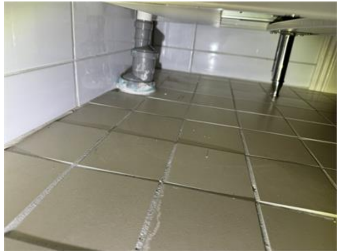
Avloppsstos är placerad när vägg i WC/dusch.
