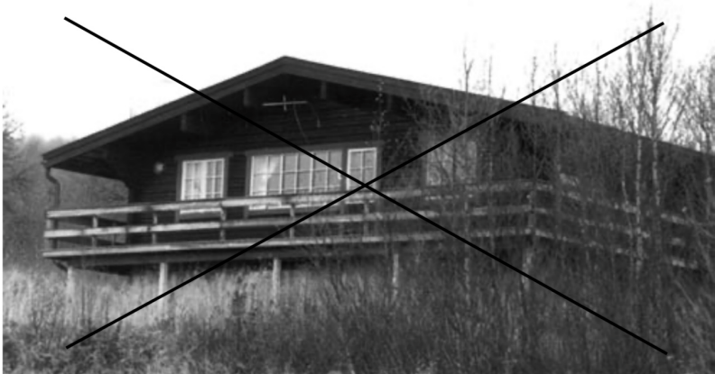
Fel stil och karaktärsdrag. För flackt tak, alltför stora takutsprång, långa fönsterband.
