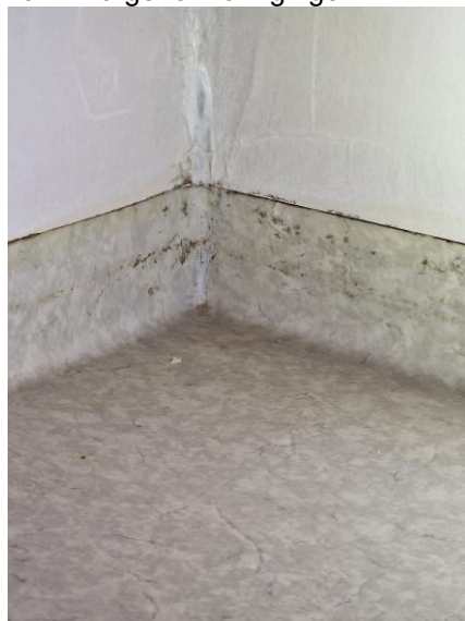
Bild 9. Vägghörn lagad med tätningsmassa.
