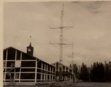
GRANATEN's antensystem år 1995, nedmonterat och flyttat till I 19 i samband med övrig flytt.
