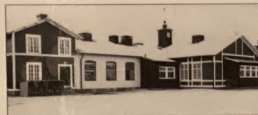
Matsalsbyggnaden med köket. Bilden tagen från NO.
