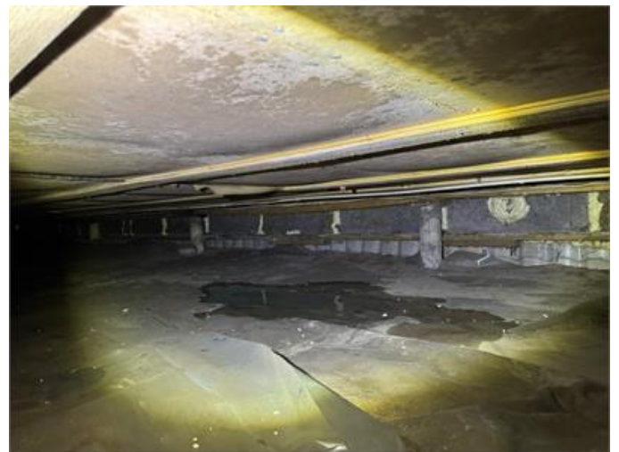
Mikrobiell påväxt på blindbotten i krypgrund och stående vatten på plastfolie.
