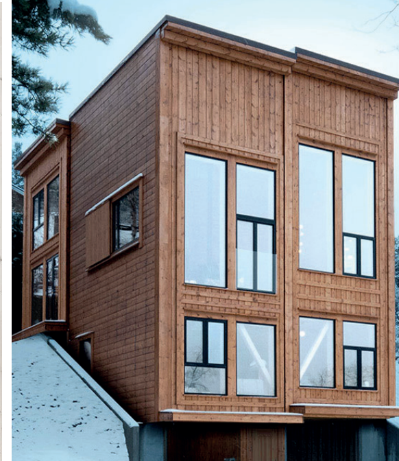
"Zieglers Nest" av Rever & Drage Arkitekter. Modernt timmerhus som kompletterats med vertikal panel på utvalda ställen.
