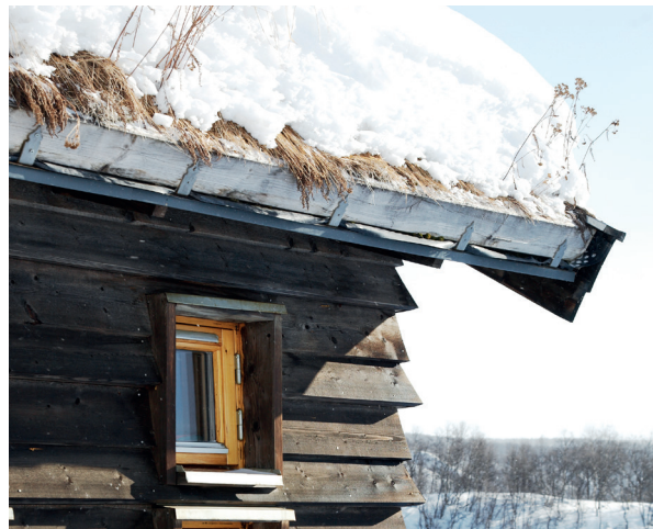
Fritidshus, Ramundberget, ritat av Murman Arkitekter. Panelens gering över hörn ger huset en tydlig karaktär. Torvtaket tillåter snön att ligga kvar.
