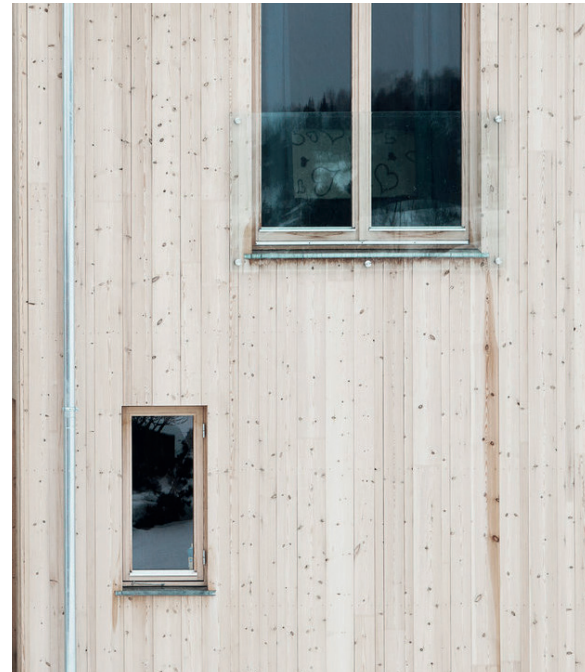
Tillbyggnad i Vinstra, Norge, av RAM Arkitektur. Ljus panel där kvistar tillåts vara framträdande och bidrar till fasadens karaktär.
