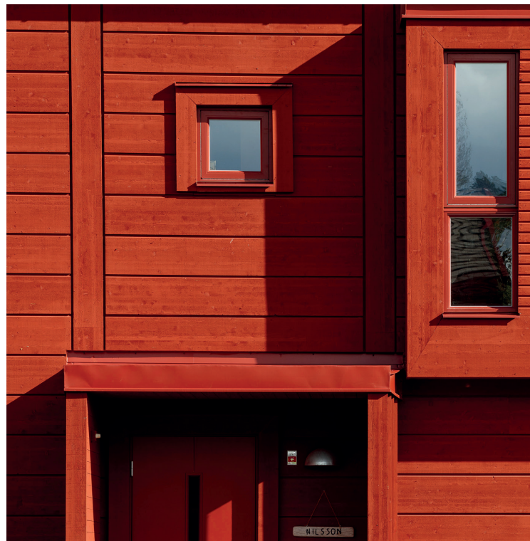
Vi vill uppmantra er till att omsorgsfullt arbeta med detaljer i fasaden. Ovan ser vi ett exempel från en villa i Rödön, ritat av Murman Arkitekter. Skarv ersätts med vertikal bräda integrerad i designen.
