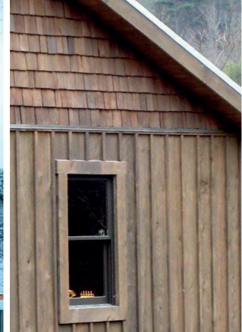
Exempel där stående träpanel kombineras med träspån högst upp på gaveln.
