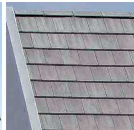
Betongplattor som fått ett skifferliknande utseende efter att järnoxid tillsatts vid tillverkningen. Ett billigare alternativ till skiffer.
