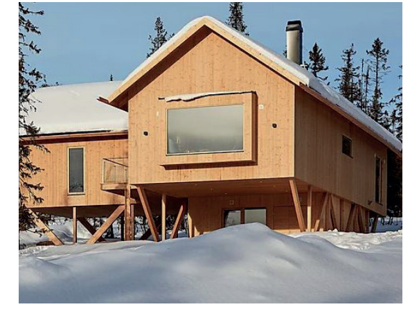
Fritidshus i Vemdalen, ritat av Wingårdh Arkitekter. Variant på uppstolpad plintgrund med snedstärvor med plats för parkering.
