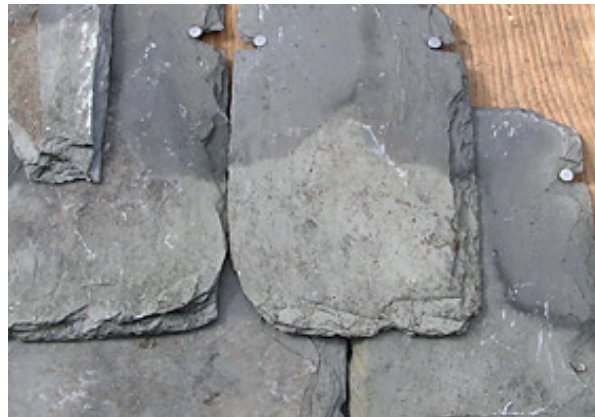
Skiffer, ett vackert och miljövänligt material som gärna får användas som taktäckning. Utöver att den tekniska hållbarheten slår många andra takmaterial är skiffer dessutom relativt underhållsfritt.
