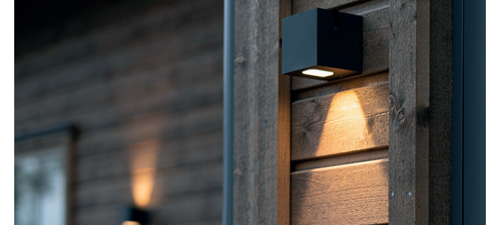
Fasadbelysning som skapar skuggverkan i panelen och bidrar med ett behagligt ljus i närmiljön när det reflekterar träets varma toner.
