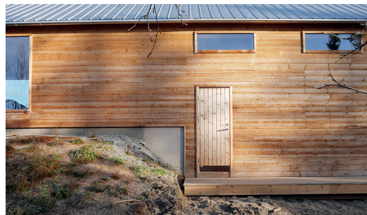
Fritidshus Ljungdalen ritad av Lowen Widman Arkitekter. Ett exempel på samtida arkitektur med tydlig traditionell förankring. Anpassningen efter marken skapar en fin interiör nivåskillnad.
